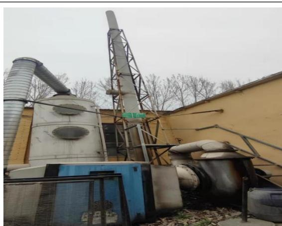
油雾分离器+喷淋塔+UV光氧+活性炭处理装置+排气筒 DA001
