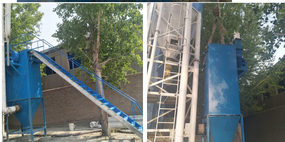
现场整改照片
